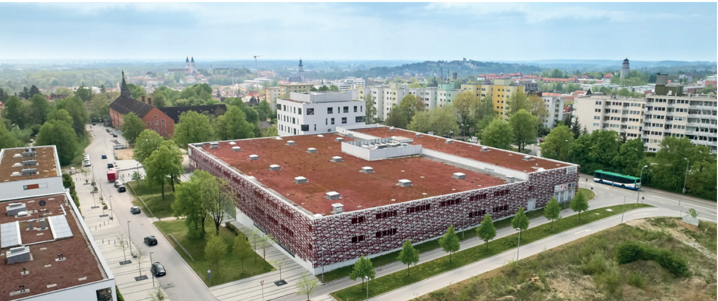
SteinCenter mit angrenzender Wohnbebauung und Entwicklungsgrundstück für Hotel- und Wohnnutzung (unterer Bildschirmrand)
