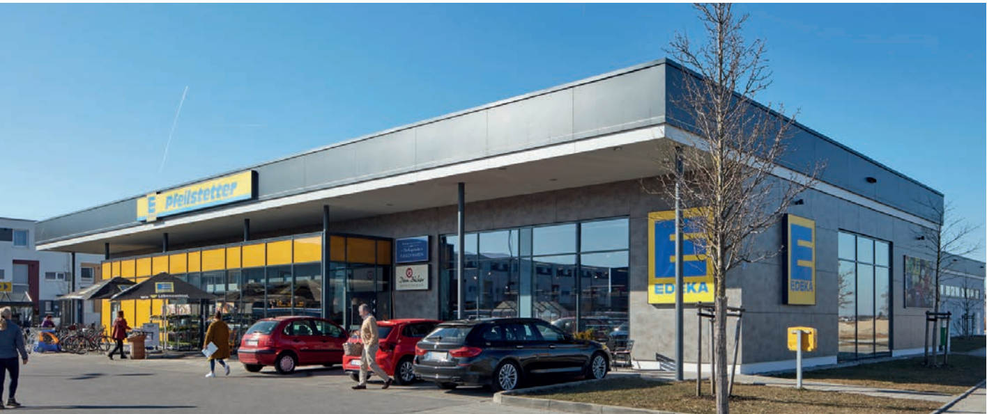
Seewinkel Center – Gebäude mit Mietbereich EDEKA
