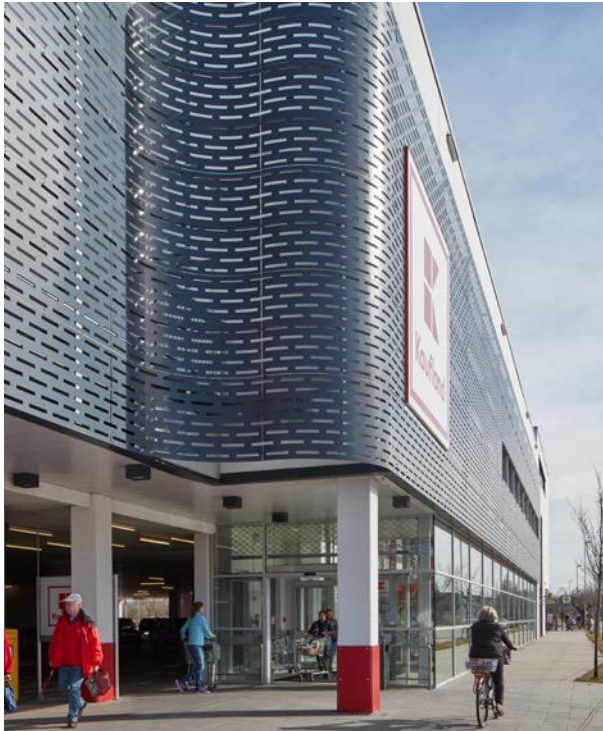
Eingangsbereich an der Münchener Straße
