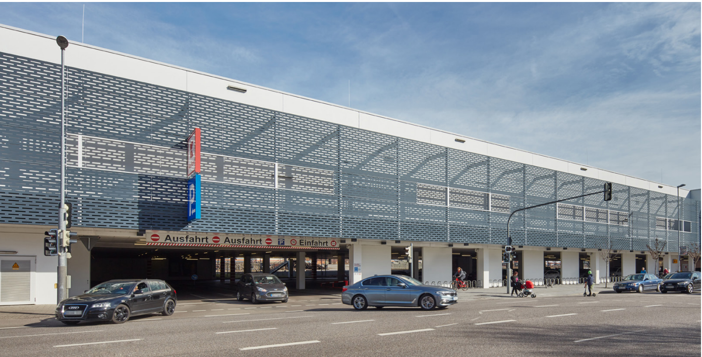
Kaufland-Center – Zufahrt von der Münchener Straße zu den ebenerdigen Stellplätzen
