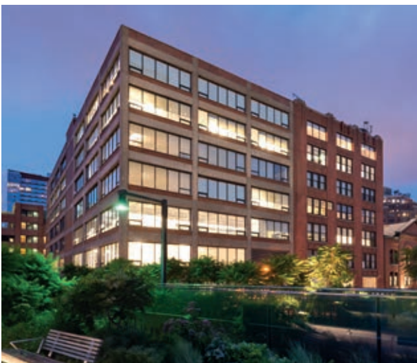
Geschäftshaus Milk Studios, New York, JAMESTOWN 27 / JAMESTOWN 28
