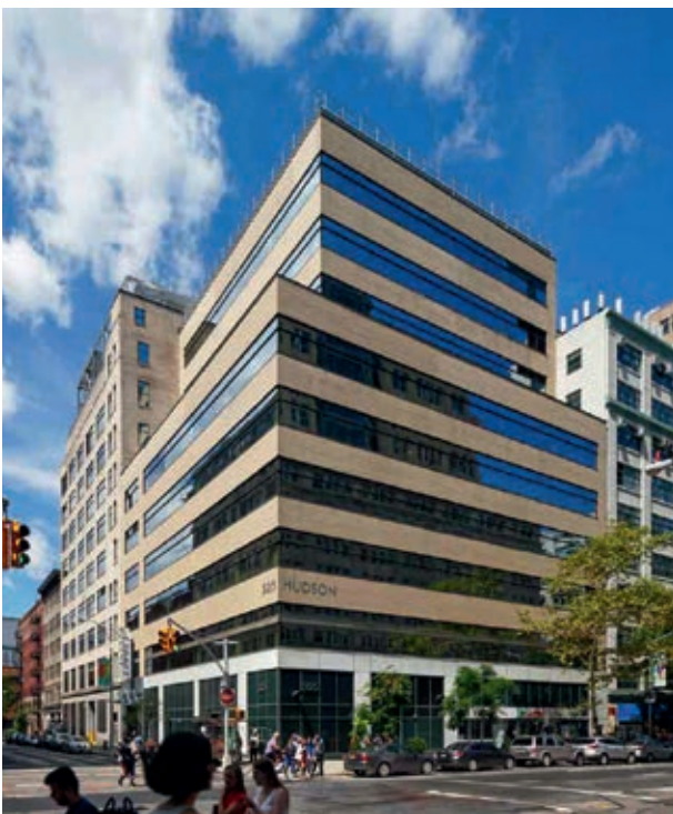
Bürogebäude 325 Hudson Street, New York, JAMESTOWN 27
