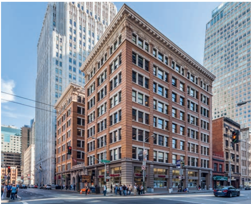
Geschäftshaus Rialto, San Francisco, JAMESTOWN 29
