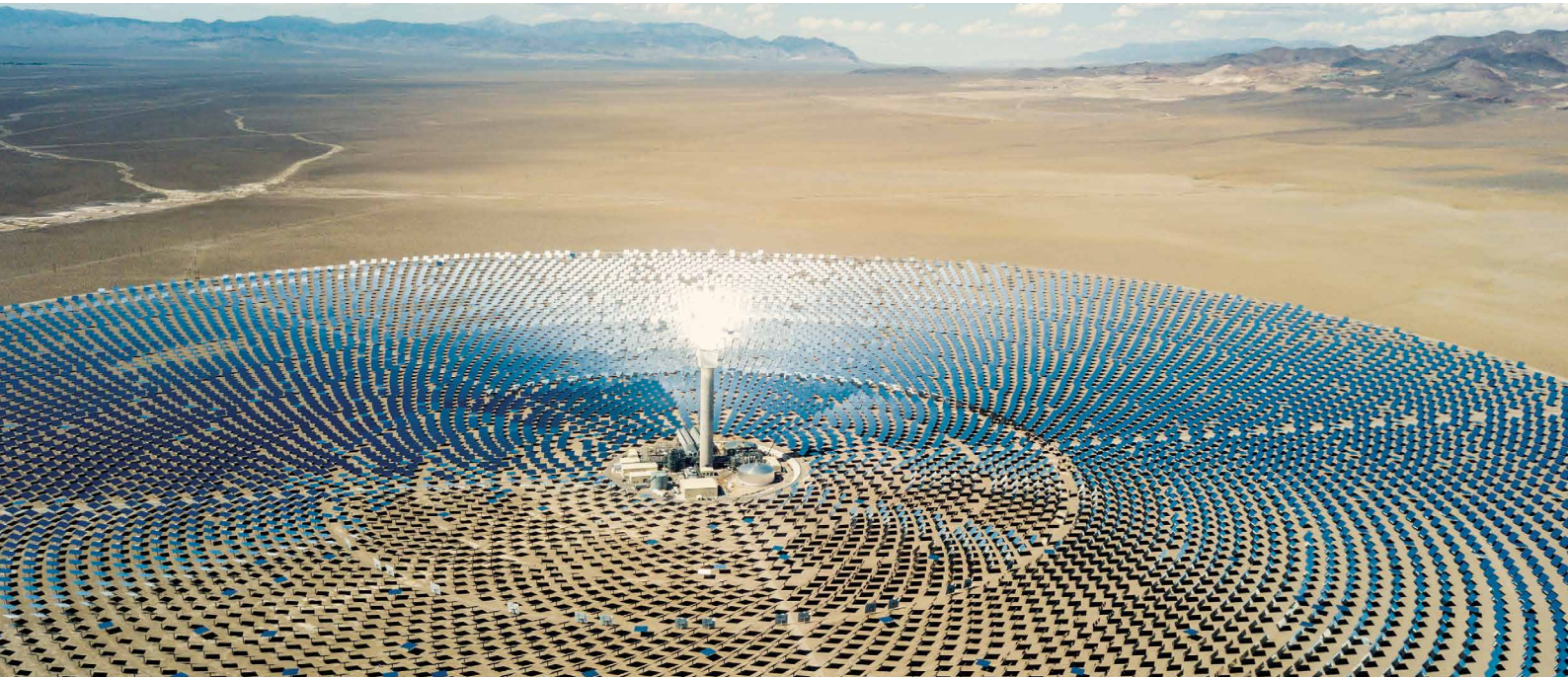
Solarwärmekraftwerk, Crescent Dunes Solar Energy Project
