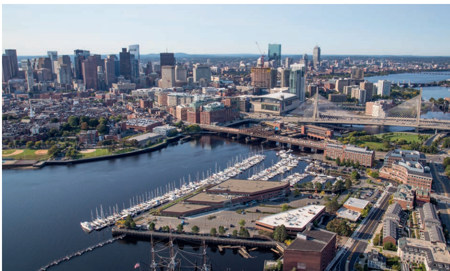
Bürokomplex Constitution Wharf 1 Constitution Road Boston, Massachusetts, USA Mietflächen in qm: 16.658 Vermietungsstand: 99%
