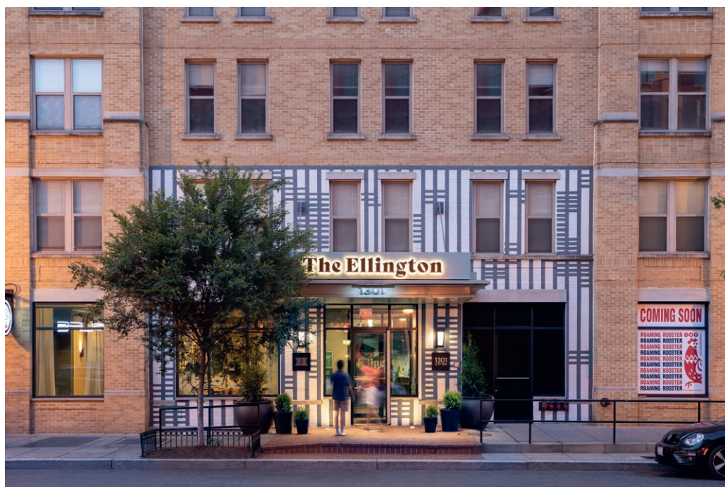
Mietwohngebäude The Ellington 1301 U Street NW Washington, D.C., USA Mietflächen in qm: 15.488 Vermietungsstand: 92%
