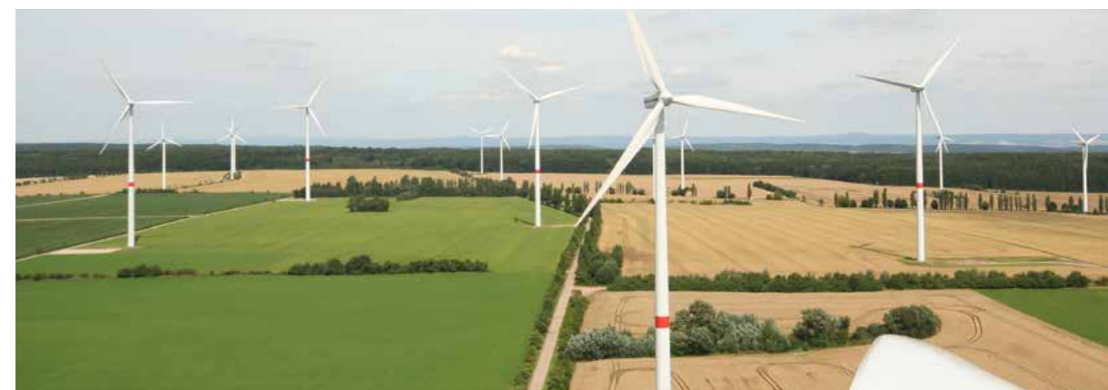
Windpark Großenehrich, Thüringen
