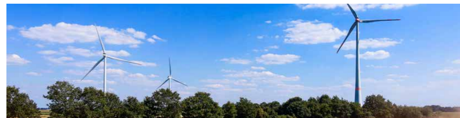
Windpark Emlichheim, Niedersachsen
